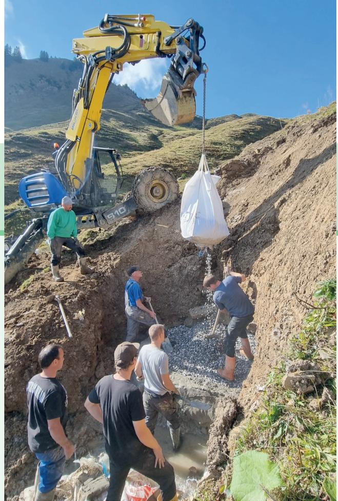
errichtet und entsprechen heute aus technischer und hygienischer Sicht nicht mehr dem Stand der Technik. Die Quellableitung Richtung Thüringerberg ist für unseren heutigen und zukünftigen Wasserverbrauch unterdimensioniert und wird nun mit größerem Leitungsdurchmesser neu errichtet.
